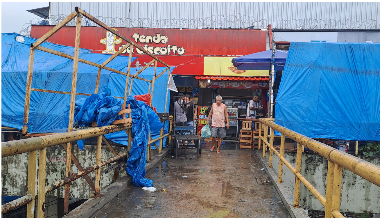
Figura 48: Fotografia de passarela de acesso à estação de transferência entre metrô e trem da Pavuna/São João de Meriti. Podem ser observados frente à frente lojas de franquias que alugam espaços da estação cedidos pela concessionária Metrô Rio e vendedores ambulantes (estantes com lona). Fonte: autora (2024).
